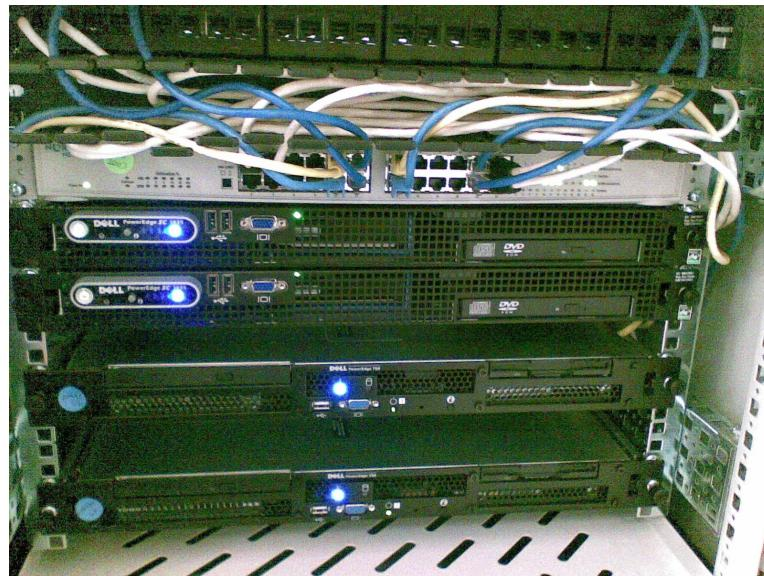
Cada uno de esas luces azules es de un server o servidor... ahí se procesa, se almacena y se controla la información que va y viene de Internet. Arriba de los servidores se puede ver un switch y el cableado blanco y azul que es lo que conecta todo el equipo entre sí.
